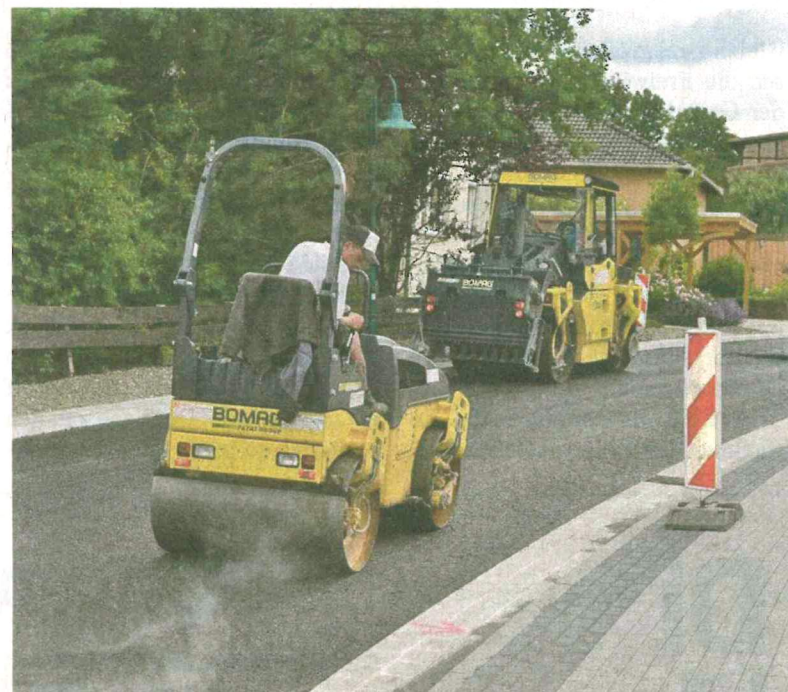
Mit Walzen, die auch mit Rüttelfunktion ausgestattet sind, wird die heiße bituminöse Tragschicht auf der Fahrbahn verdichtet.
