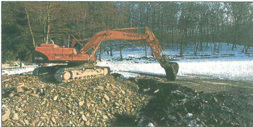
Baggereinsatz am Clarabadteich.
