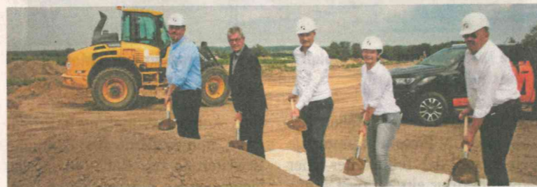
Startschuss für das Baugebiet Bäckerweg Ost: Den ersten Spatenstich übernehmen (von links) Bauunternehmer Thomas Meyer, Gemeindevorstand Rüdiger Fricke, Planer Lars Kuhn, Sina Kemmer vom Erschließungsträger sowie Bürgermeister Hans-Hubertus Broistedt. ERIK BEYEN
