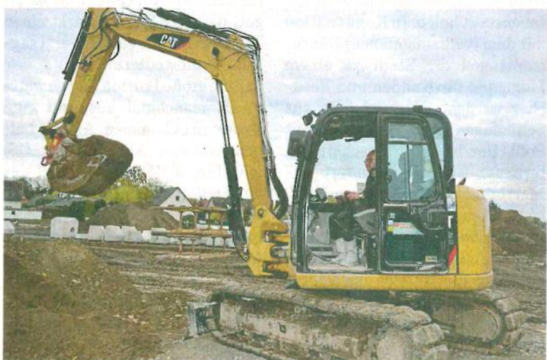
Bürgermeister Rainer Angerstein setzte mit dem Bagger den offiziellen Spatenstich für das Baugebiet Bischofsberg.
